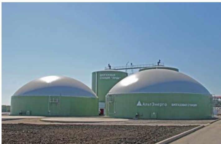
Рис. 4.14. Биогазовая станция «Лучки»
