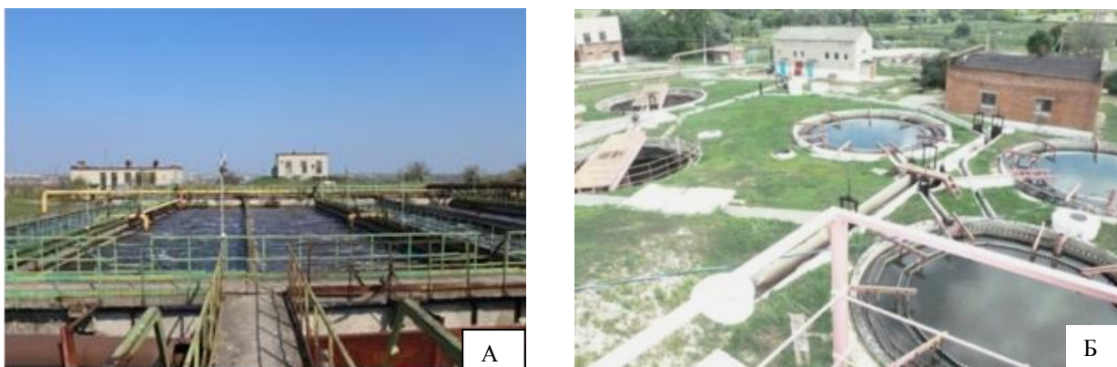
Рис. 4.33. Очистные сооружения: А - Аэротенк в г. Губкине, Б - МУП Водоканал г. Валуйки
